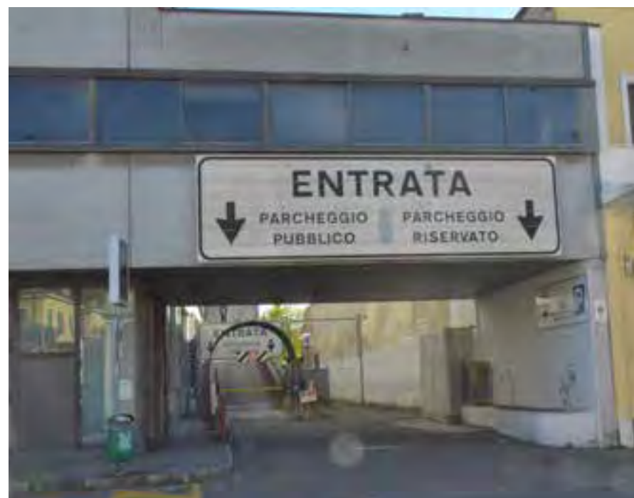
Sopra, l'entrata automatizzata che permette di accedere al garage sfruttando le comode rampe, frutto di uno speciale studio. La struttura dispone di 448 posti.
